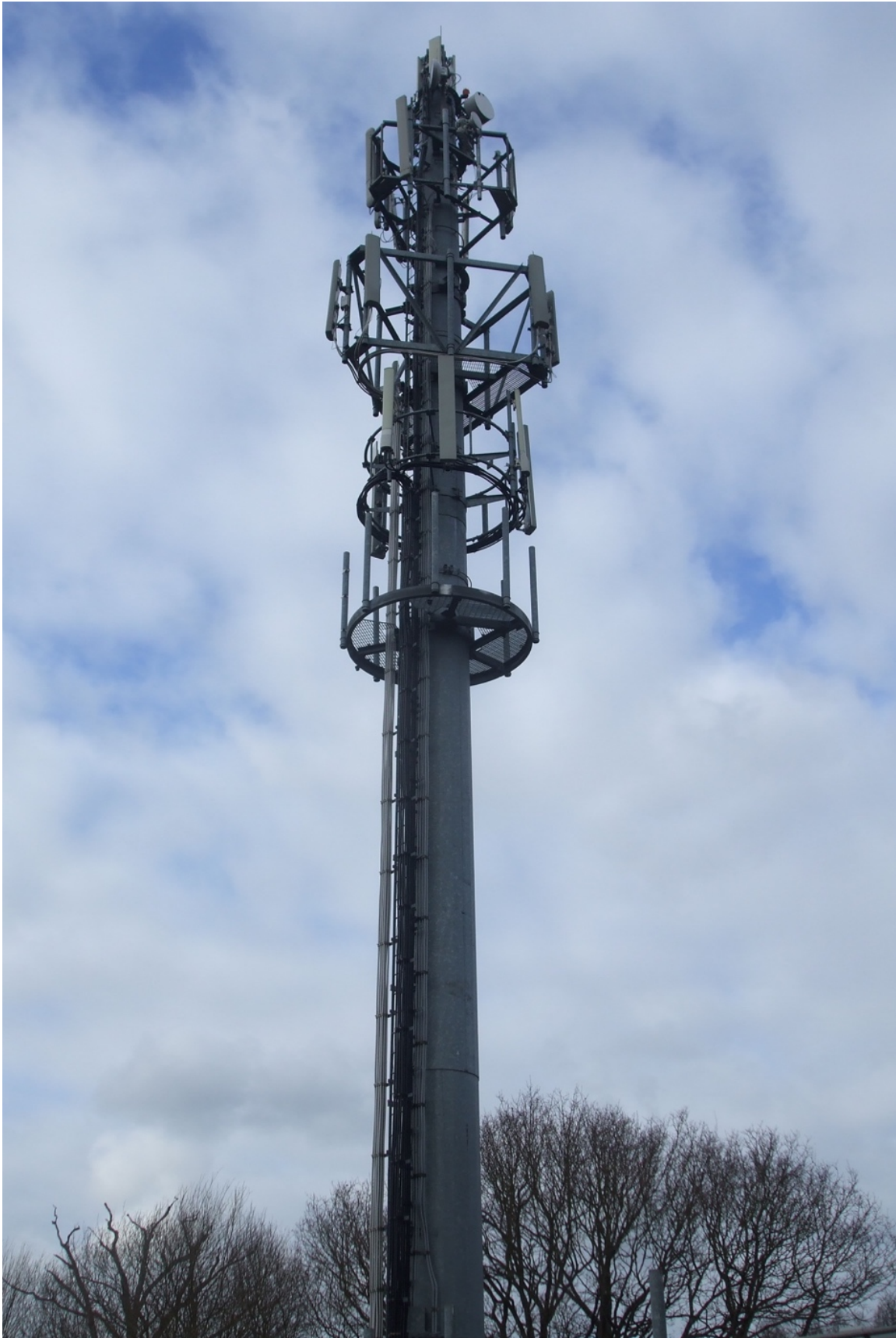
Figure 1-4 Mizens Farm monopole. J. A. Jimenez Capilla. July 2017. Arqiva.
