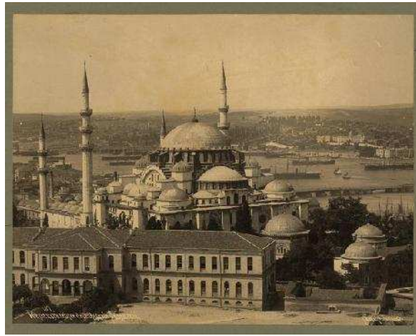
Vue panoramique de la Mosquée Suleymanié / Sébah & Joaillier around 1900 14
