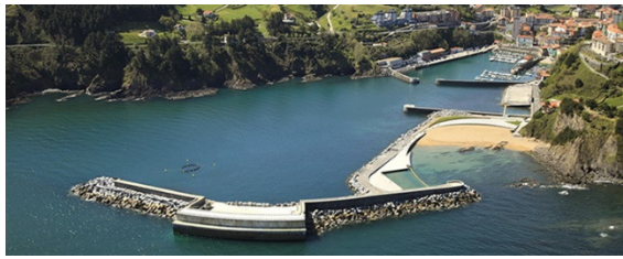
Figure 2.3. Mutriku breakwater wave power plant (Ente Vasco de la Energía, 2017)
